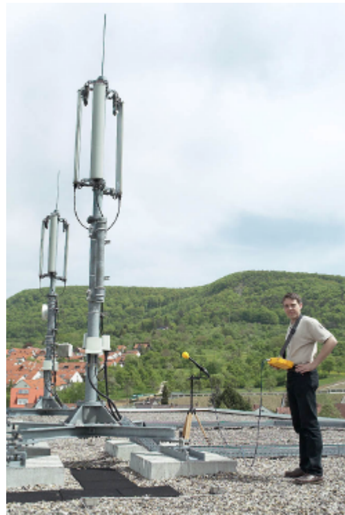
Vergleichsmessung auf dem Dach. Für Präzisionsmessungen positioniert man die Sonde auf einem Stativ. Um „Hot Spots“ zu finden – die Stellen mit der größten Feldstärke – nimmt man die Sonde einfach in die Hand.
