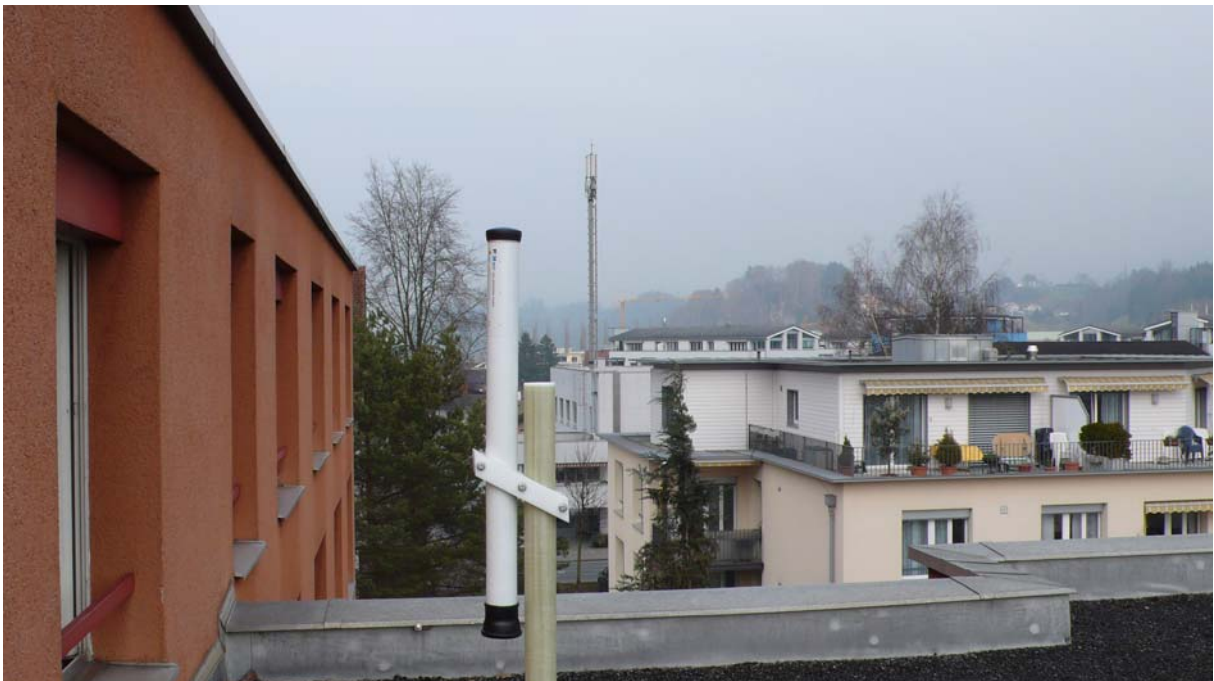
Bild 1: Messsonde am Messort "Sarnen" (Flachdach eines Seniorenheims). Im Hintergrund ist ein Mobilfunksendemast zu sehen.
