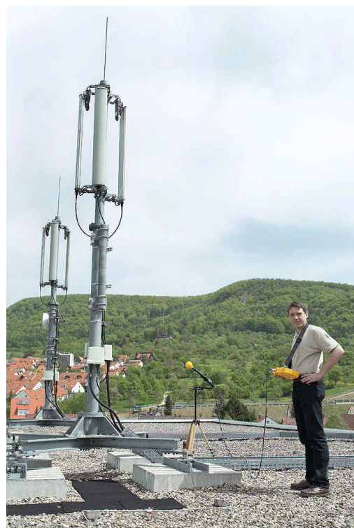
Misurazione comparativa sul tetto
